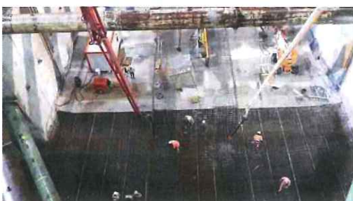
Coulage puits station métro
