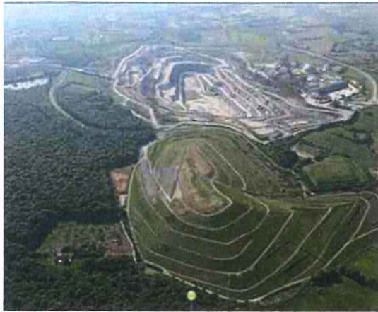
Merlon de la prise Goberon (achevé)
